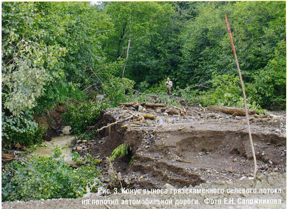
Рис. 3. Конус выноса грязекаменного селевого потока на полотне автомобильной дороги. Фото Е.Н. Саложникова
