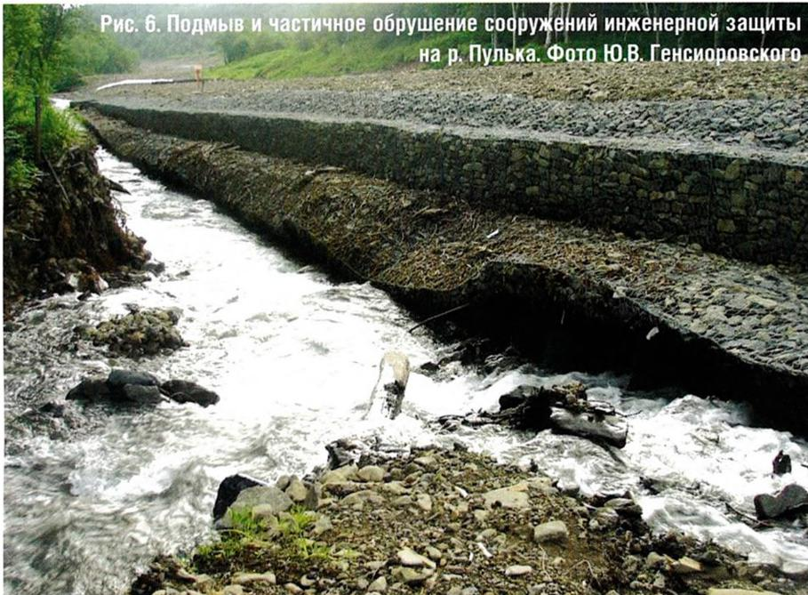
Рис. 6. Подмыв и частичное обрушение сооружений инженерной защиты на р. Пулька. Фото Ю.В. Генсировского
