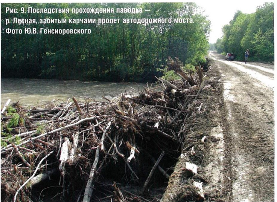
Рис. 9. Последствия прохождения паводка — р. Лесная, забитый карчами пролет автодорожного моста. Фото Ю.В. Генсировского
