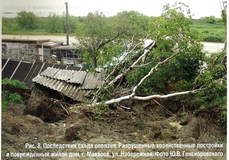
Рис. 8. Последствия схода оползня. Разрушенные хозяйственные постройки и поврежденный жилой дом, г. Макаров, ул. Набережная. Фото Ю.В. Генсировского
