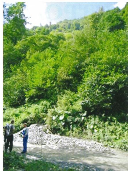
**Рис. 3, 4. Отложения техногенного грязекаменного селя 19–20.08.2010 г. на автомобильной дороге в долине р. Пслух (Красная Поляна) (19–20.08.2010 г. Фото Н.А. Казакова)**
