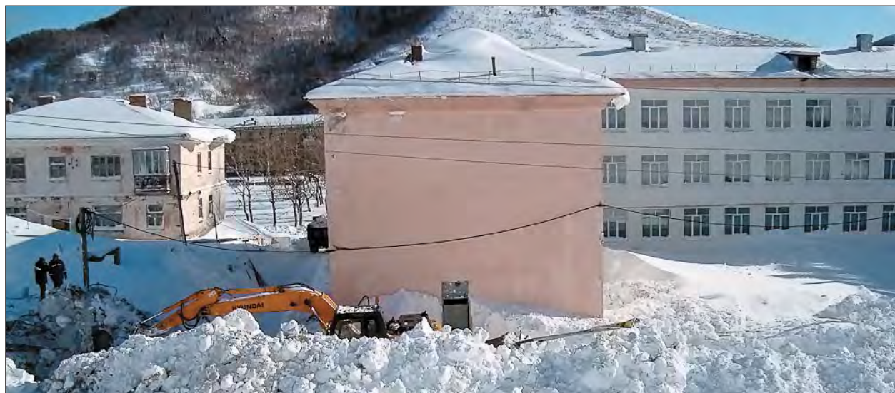
Отложения лавины, повредившей здание школы в с.Чехов.
