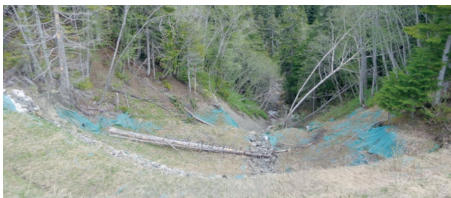
Рис. 5. Активный оползень на одном из участков трассы, способствующий накоплению материала в русле селеной реки. Фото Ю.В. Генсировского
