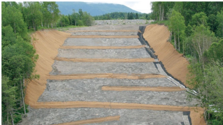
Рис. 1. Склон после завершения технической рекультивации по одному из участков трассы нефтегазопроводов в Макаровском районе (Центральный Сахалин). Дата снимка 07.2007 г.
